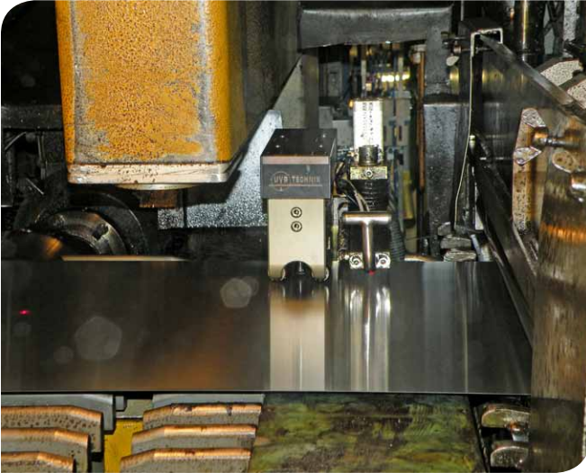
C.D. Waelzholz (závod Wickede), Německo, bimetal, válcovací stolice – Kontaktní měřič tloušťky používán pro on-line kalibraci X-ray měřiče
